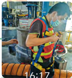
現場組織搭架設備及檢測氣體濃度
